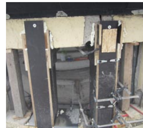
Forskalling omkring armerede betonsøjler mellem vinduer.
